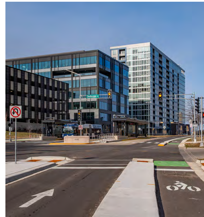
La intersección rediseñada de Sheboygan Avenue y Segoe Road
