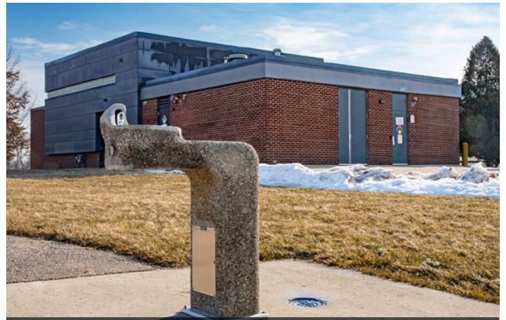
El Pozo 15 de Madison Water Utility, actualmente fuera de servicio
